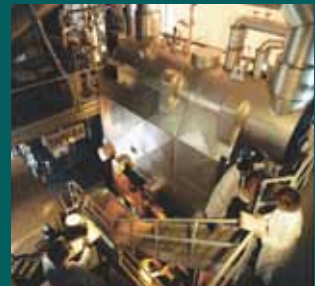
Optimierung der Anlagen
